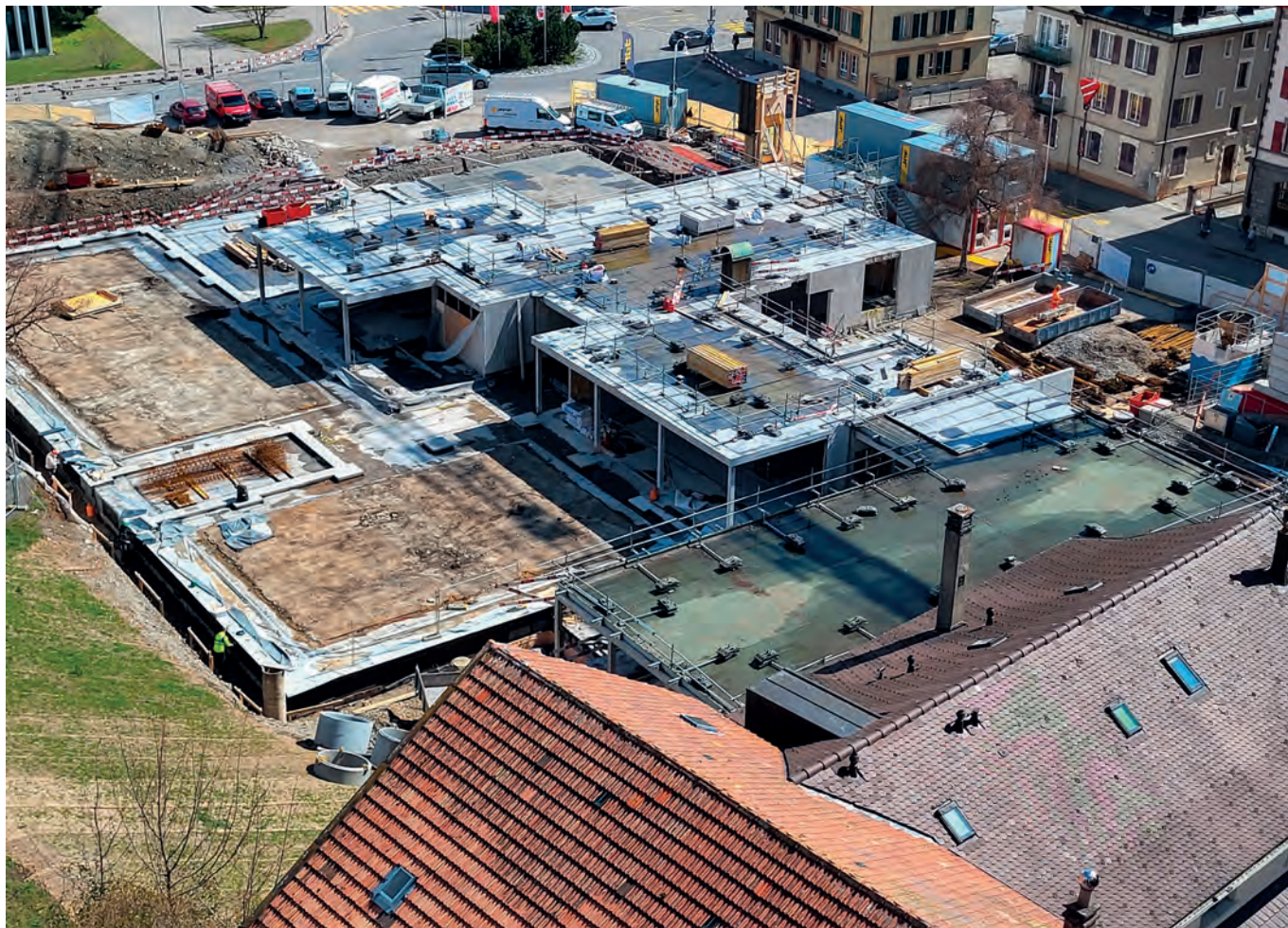
Le chantier dans toute son étendue, vu depuis le donjon du château. La structure centrale est celle de 1978, plus l'ajout de 2012 pour l'agrandissement de la bibliothèque. Les surfaces au sol, dont on a retiré le gazon, correspondent à la construction sous-jacente, comprenant le musée et les réserves. Le nouveau bâtiment couvrira l'intégralité de cette surface. Photo Serge Rossier.
