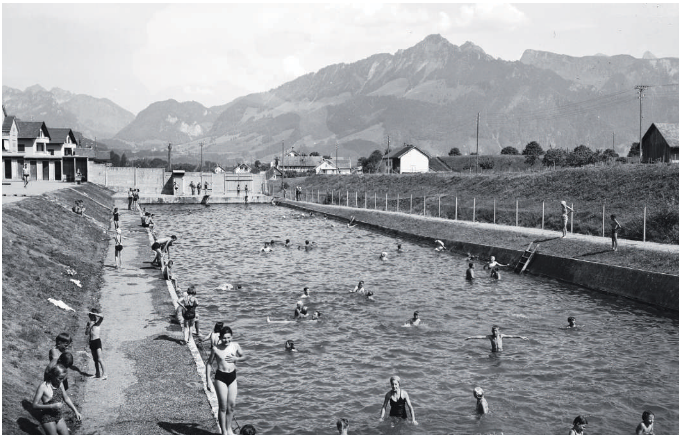
Dès 1930, la piscine de Bulle dispose de trois terrasses, d'où «l'on jouit d'une superbe vue sur la ville de Gruyères et les Alpes». Bulle, piscine, 1937. Photo Glasson / Musée gruérien.
